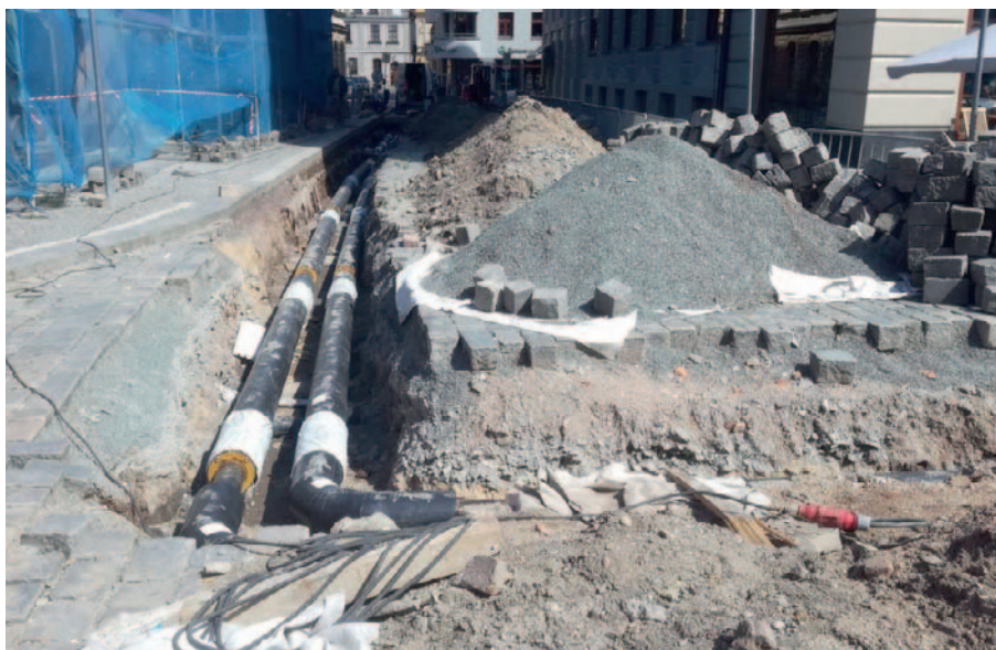
Teplovod a přípojka pro dům čp. 141 v ulici Klicperova, okrsek PS A18
