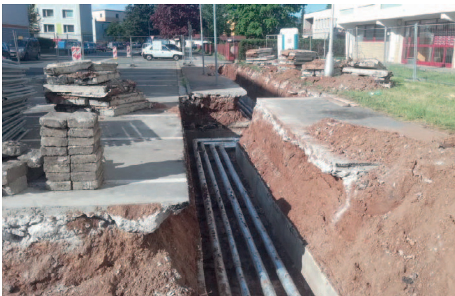
Rekonstrukce teplovodu – příp. pro MŠ Hrubínova, okrsek PS B02 – původní potrubí
