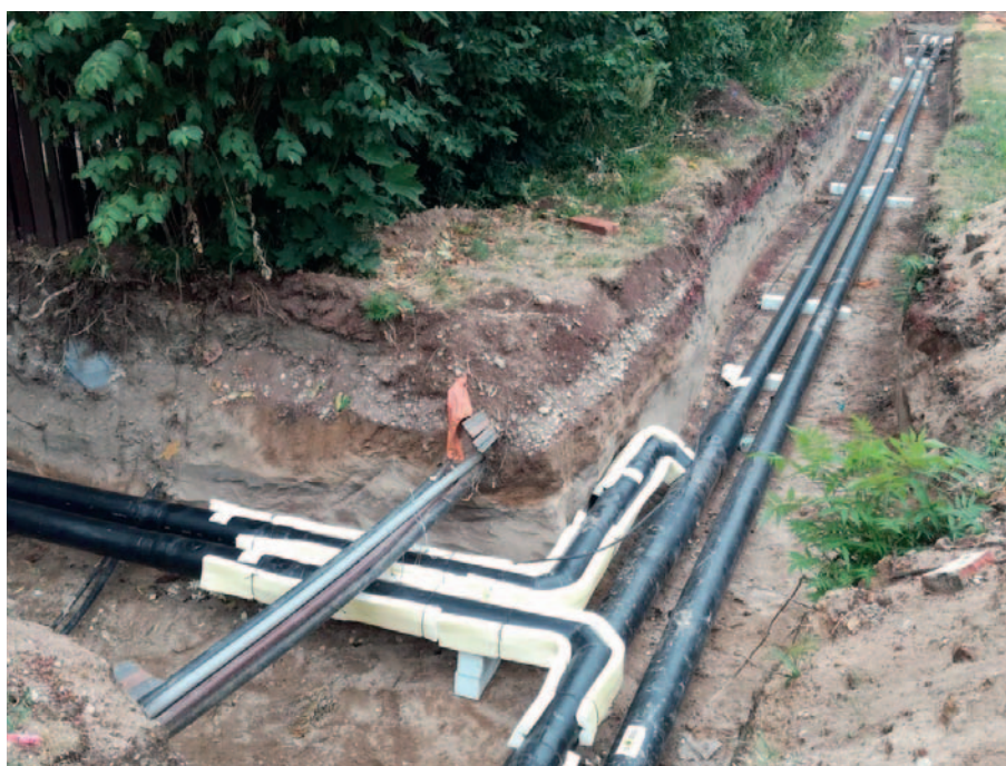
Přeložka teplovodu ul. Na Kotli 1163-1170, okrsek PS C11
