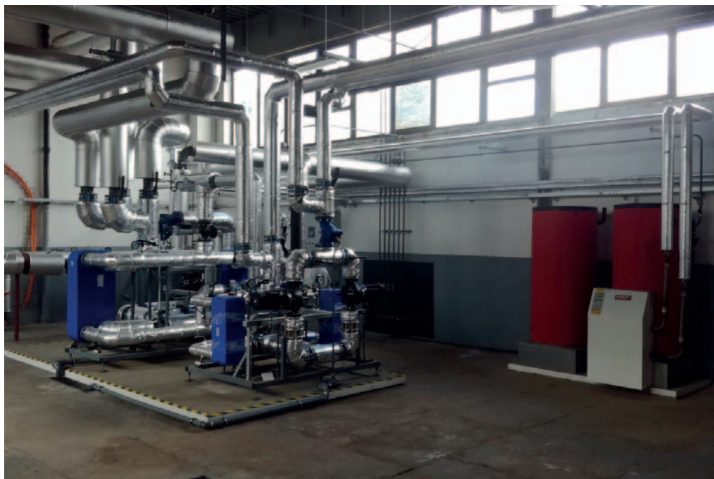
Technologie PS A23 Gagarinova ul. – po rekonstrukci
