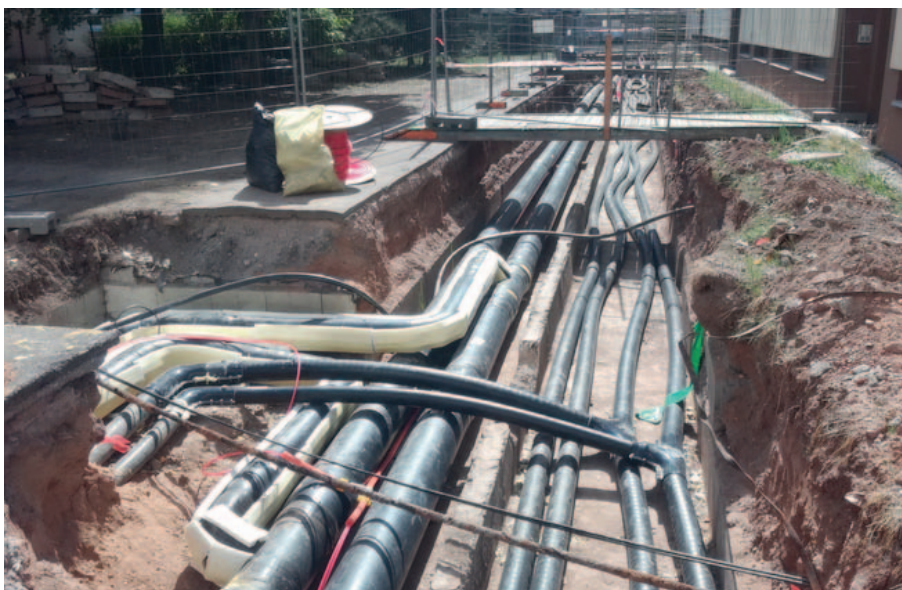
Rekonstrukce teplovodu Jungmannova, Hrubínova, okrsek PS B02 – nové potrubí
