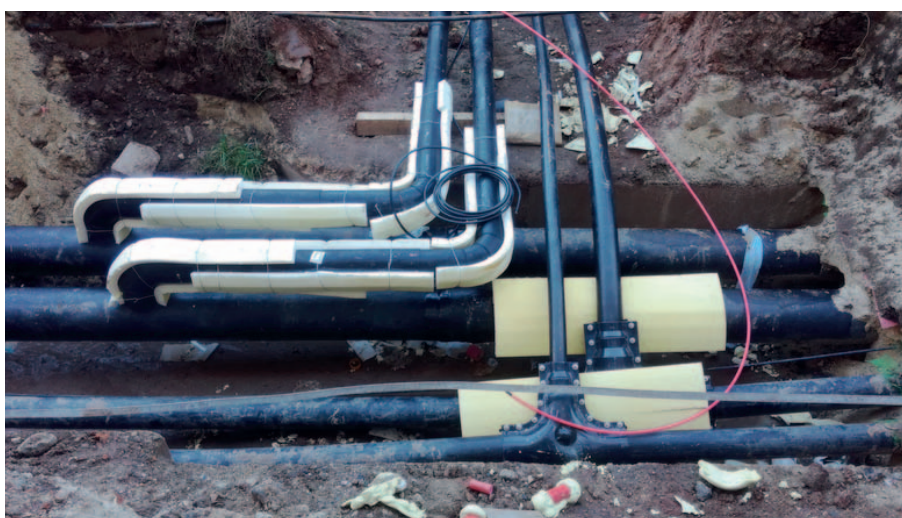
Teplovodní přípojka pro bytový dům Seydlerova, okrsek PS B03
