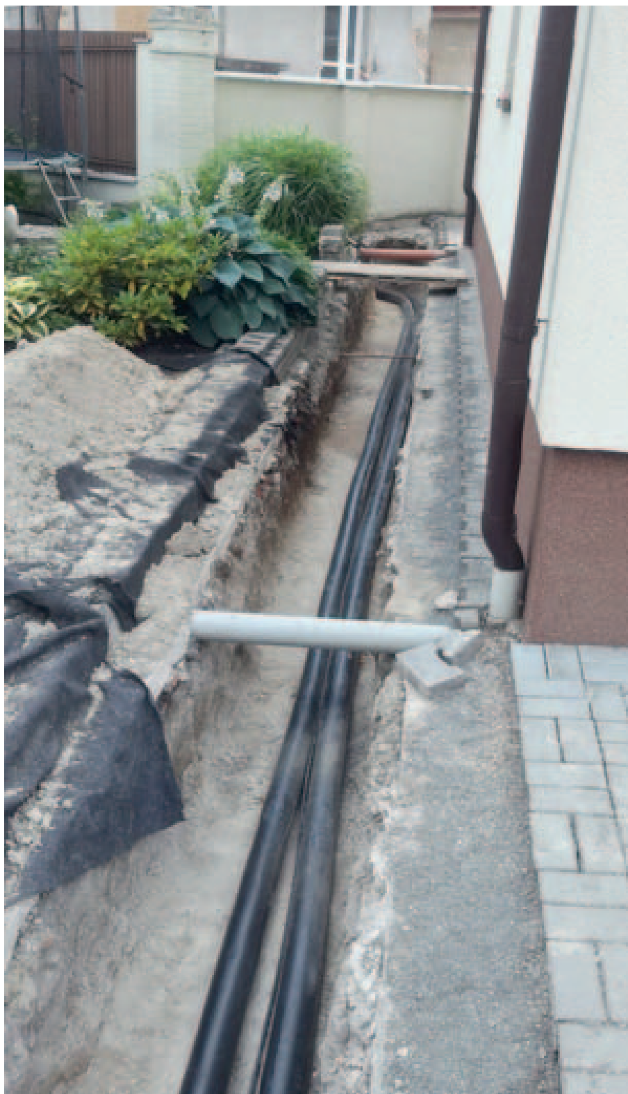
Teplovodní přípojka pro dům čp. 136 v ulici Bratří Štefanů, okrsek PS A30
