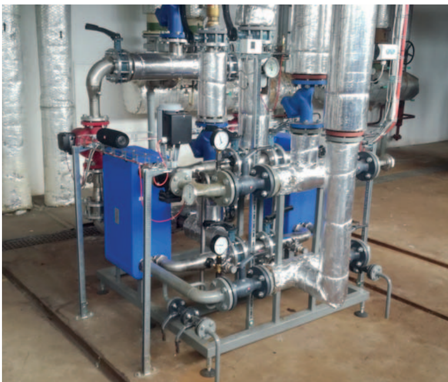
Technologie přípravy TeV v PS C24 ul. Jana Masaryka – po rekonstrukci
