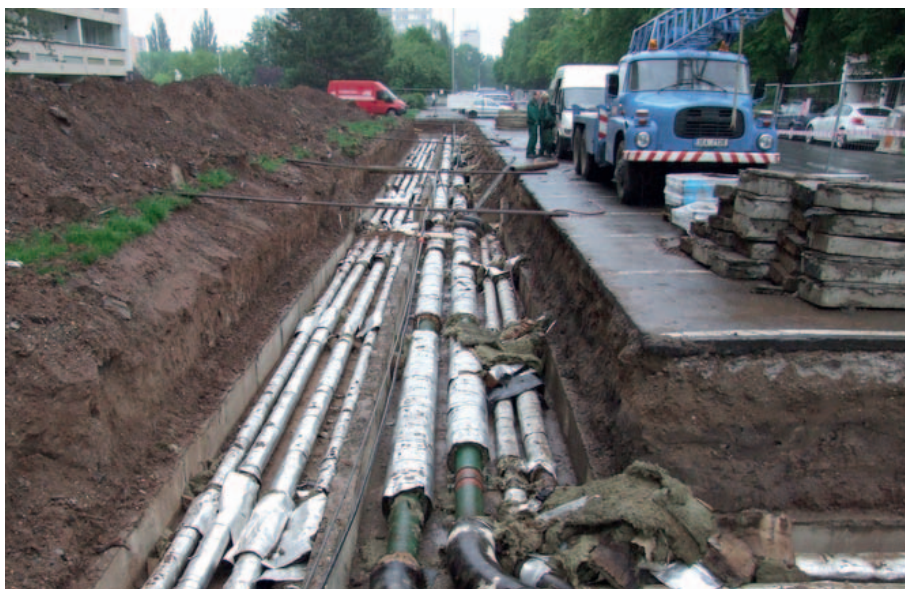
Rekonstrukce teplovodu Jungmannova, Hrubínova, okrsek PS B02 – původní potrubí
